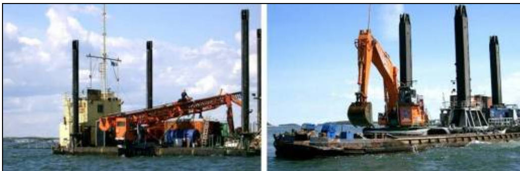
Ilustracja 3.4 Przykłady barki do wierceń i wysadzania wybuchowego (z lewej strony) i barka do pogłębiania (z prawej strony) pracujących w Zatoce Fińskiej, rok 2004
